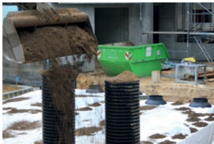
Funkce ochranného poklopu při zásypu
