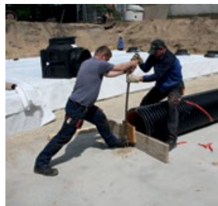
Montáž sedimentační trubky
