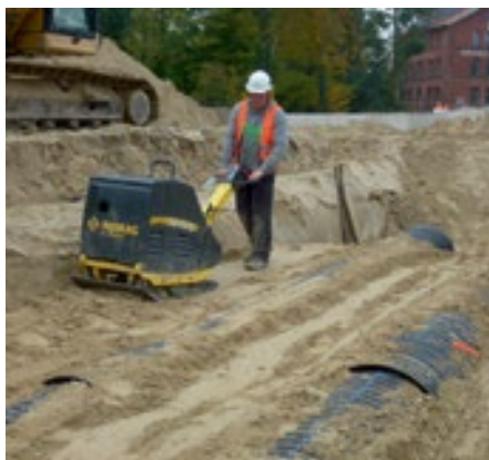
Zhutnění bočního zásypu
