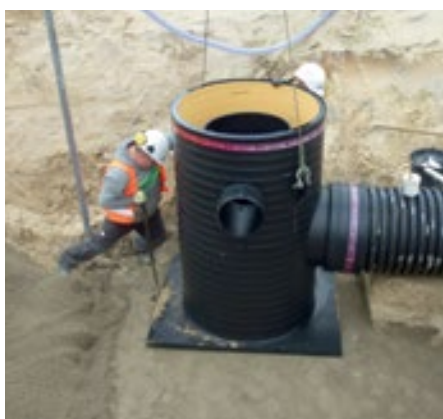
Montáž cílové šachty
