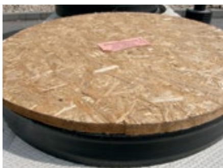
Ochranný poklop u šachty s betonovou krycí deskou
