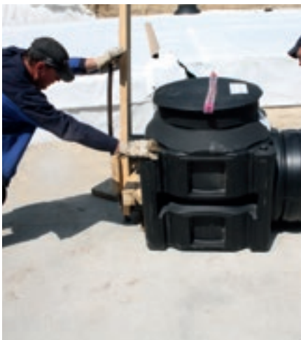
Montáž cílové šachty
