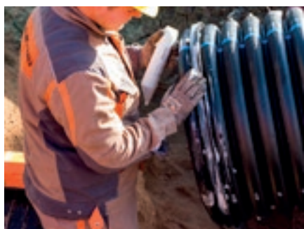
3. Potření těsnicího kroužku kluzným prostředkem
