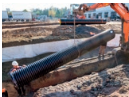
2. Umístění sedimentační trubky do montážní polohy
