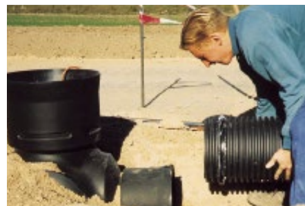
Instalace je bezproblémová díky nízké hmotnosti. Příslušné díly příslušenství splňují veškeré požadavky na praktické použití drenážního potrubí.
