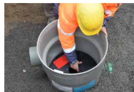
Výměna clony
