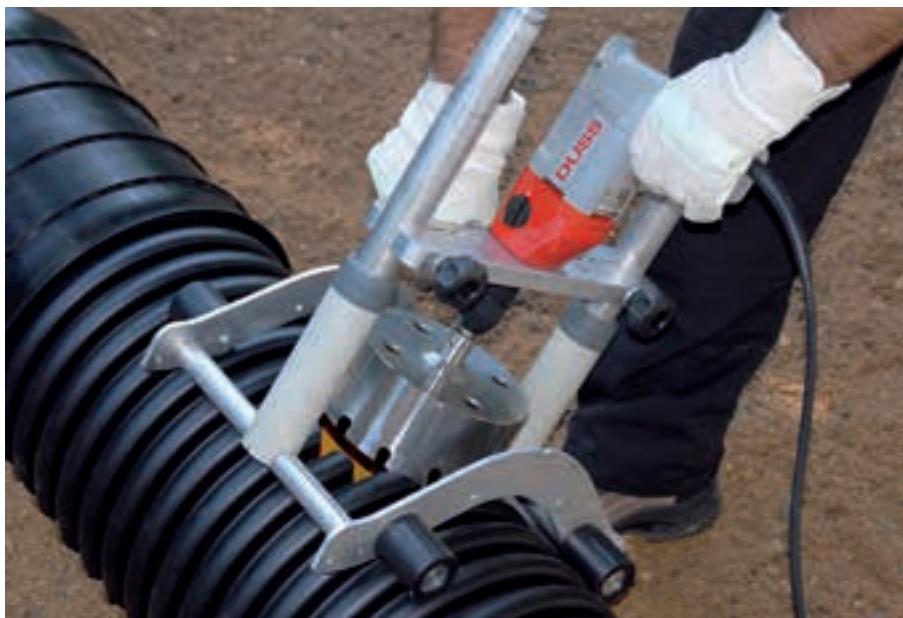
Navrtání pomocí vrtacího stativu
